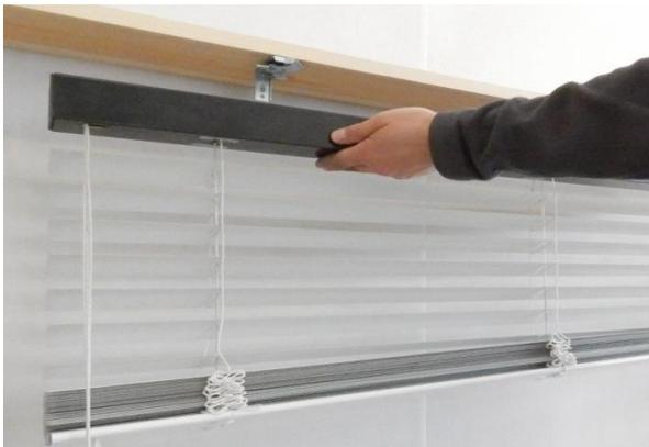
6. Fixez le rail avec le paquet de lames aux supports (photo 7), puis fermez les supports (photo 8)
