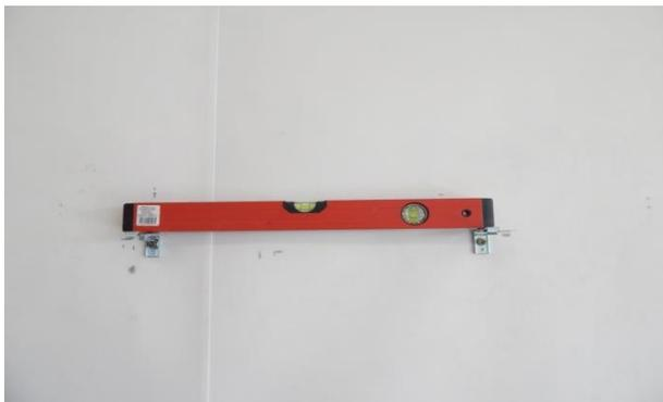
5. Vérifiez le niveau des supports montés. Si nécessaire, corrigez leur positionnement.
