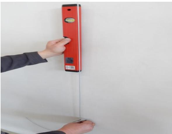
2. Utilisez un niveau à bulle pour marquer l'emplacement d'installation des équerres angulaires du guide-câble.
