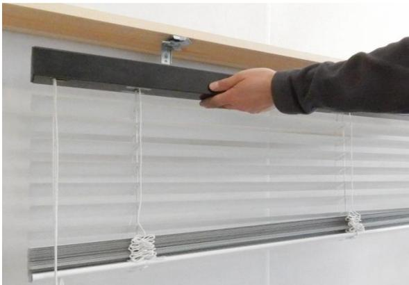
1. Fixez le rail avec le paquet de lames grâce aux supports (photo 2), puis fermez les supports.
