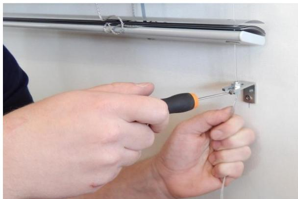
7. Serrez puis verrouillez les guide-câbles dans les manchons. Vérifiez la verticale des guides. En cas d'écart par rapport à la verticale, effectuer des réglages en positionnant correctement le manchon dans le support angulaire. Coupez tout excès de câble.
