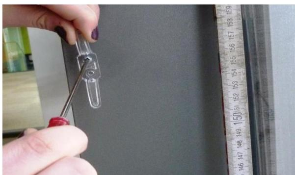
1. 1. Fixez au mur en serrant le crochet de fixation du cordon SLIM inclus - à une hauteur minimale de 150 cm au-dessus du sol.
